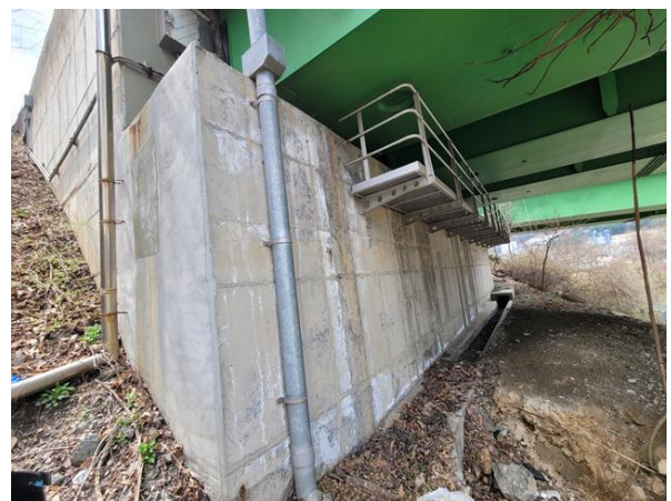
교대 A1 전경
