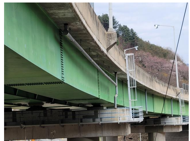
배수시설 배수관 전경
