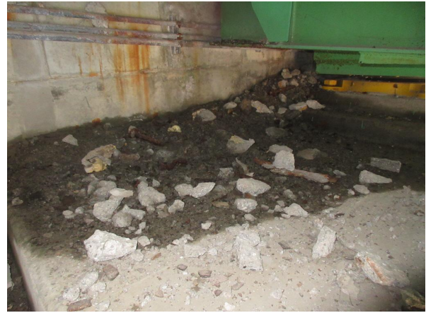
교대 폐콘크리트 적치 A1
