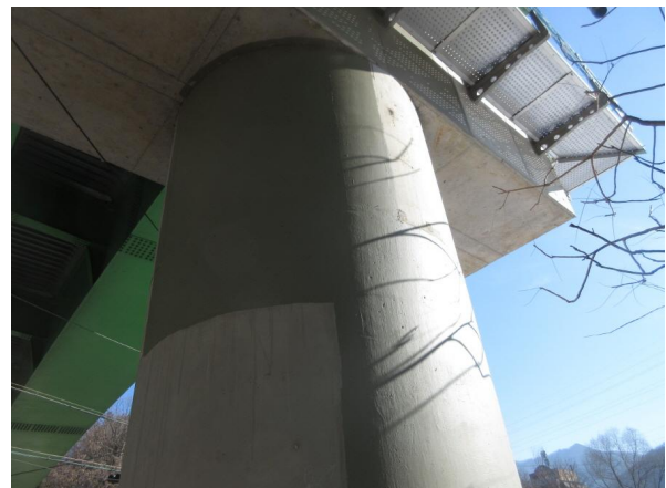
교각 보수상태 양호 P2
