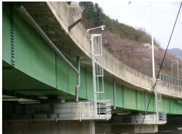
점검시설 상태양호 P1
