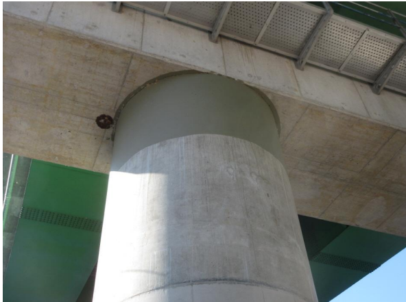
교각 보수상태 양호 P1
