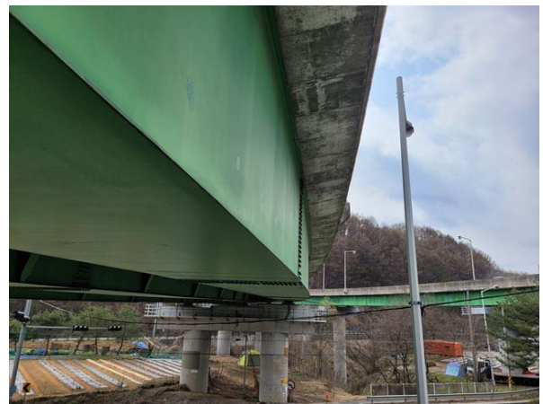
바닥판 하면 캔틸레버 전경
