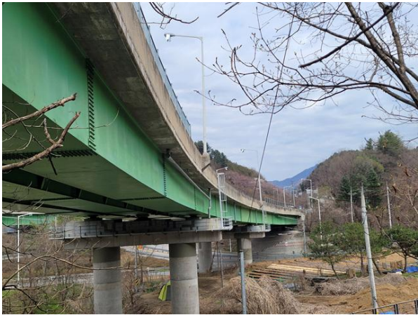
부대시설 가로등 전경
